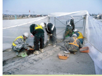
2. 既設ジョイント撤去
